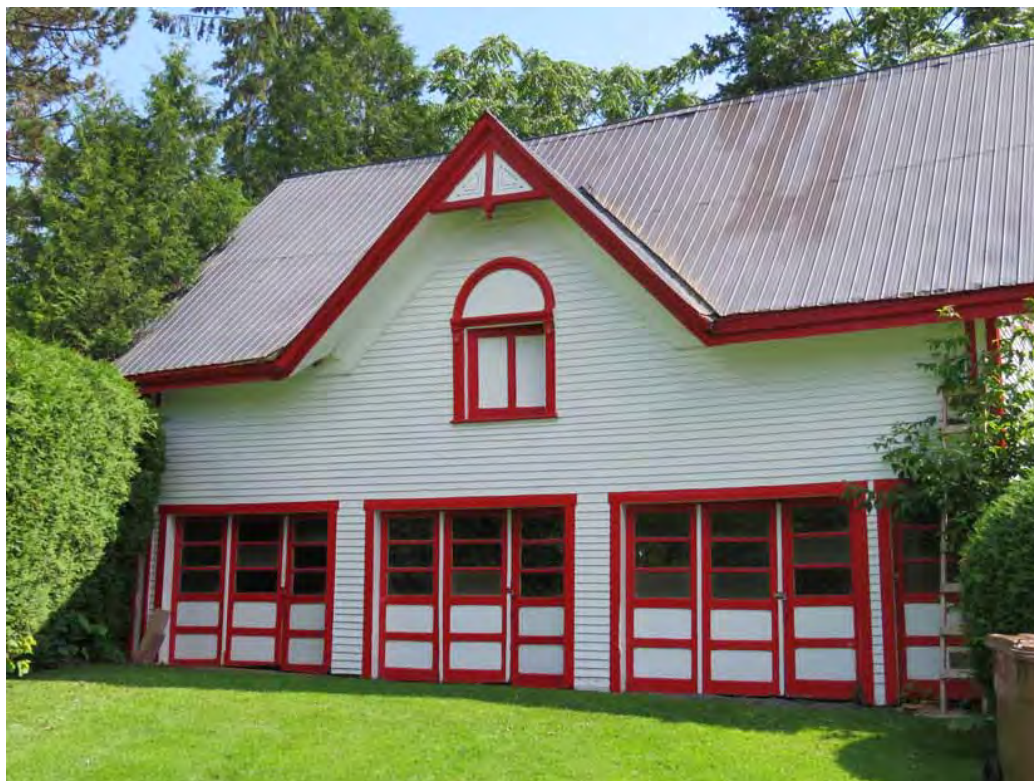
Ancienne écurie au 78-80, rue Grove, Danville. IMG_3363.jpg
