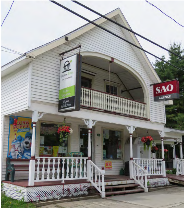
L'une des rares maisons à loggia localisées à l'extérieur de Danville dans la MRC des Sources : le 108, rue Desrivières à Saint-Camille. IMG_4643.jpg
