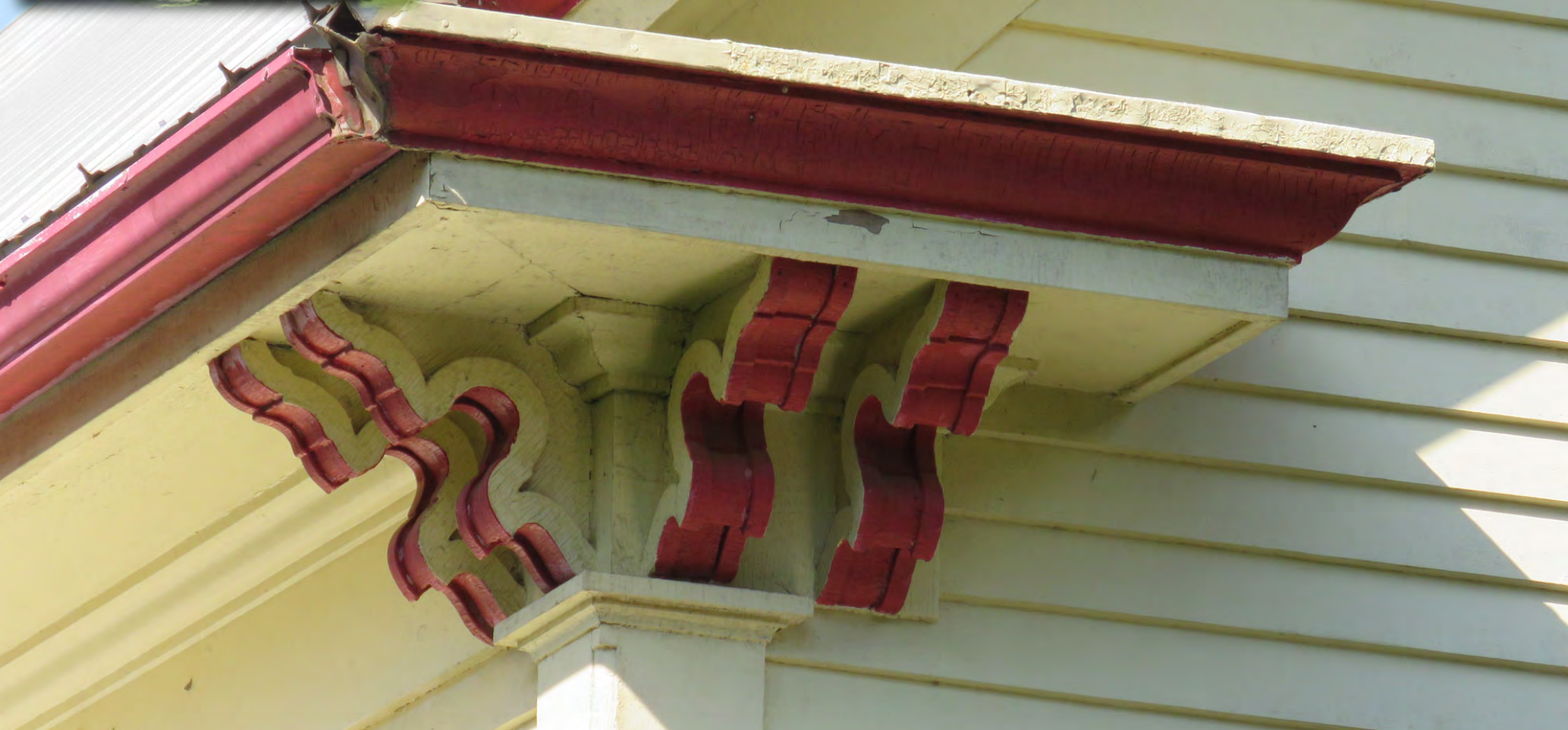
Retour de corniche et paires de consoles doubles découpées, d'influence Bracketted Style. 82, rue Crown, Danville. IMG_3798.jpg
