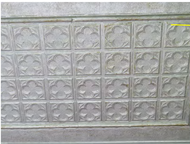
Ornement de plafond d'une galerie en tôle matricée aux motifs de trèfle à quatre feuilles. Ancien presbytère de Wotton. 772, rue Saint-Jean, Wotton. IMG_4225.jpg
