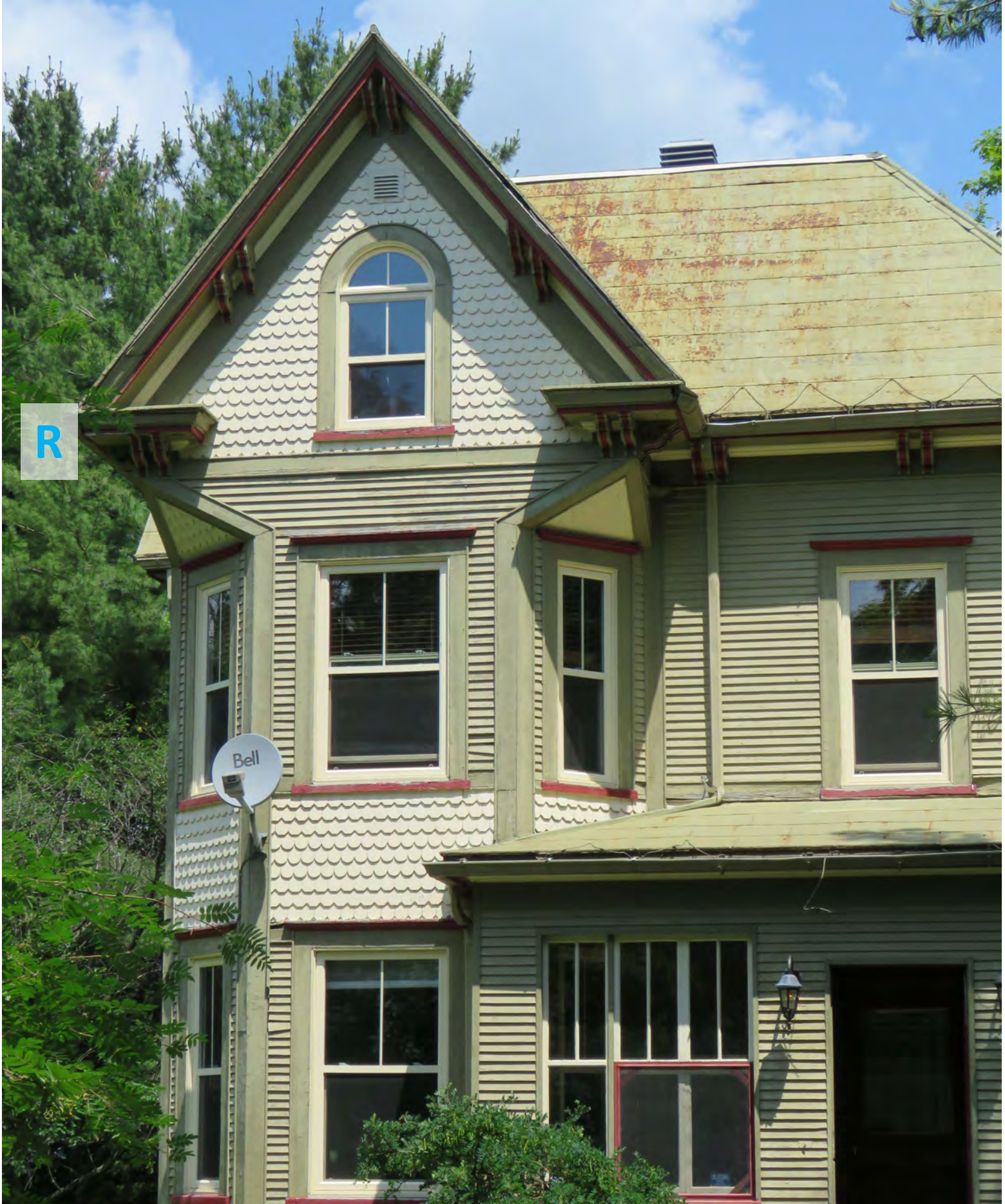
Oriel à trois pans, avec fronton et retours de corniche (R). Revêtement de planche à clin et de bardeau de bois découpé. 33, rue Dufferin, Danville. IMG_3295.jpg
