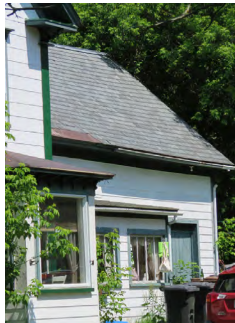
Ardoise sur le corps secondaire du 97, rue Saint-James, Danville. IMG_3905.jpg
