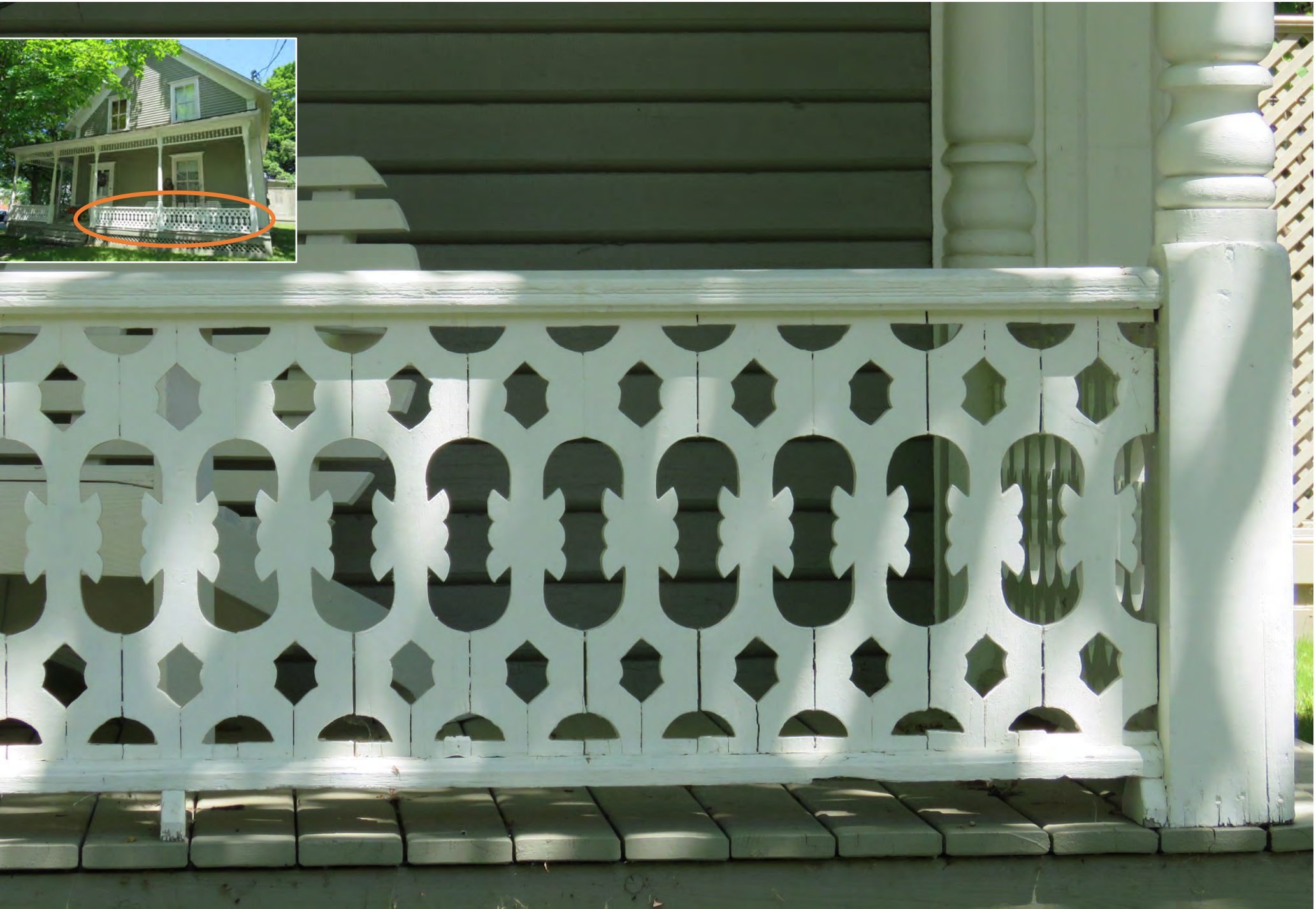
Garde-corps à motifs originaux découpés à jour. 25, rue du Prince-Albert, Danville.
