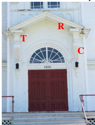
Portail à fronton, retour (R) de corniche, têtes (T) de colonnes et consoles (C). IMG_4340.jpg
