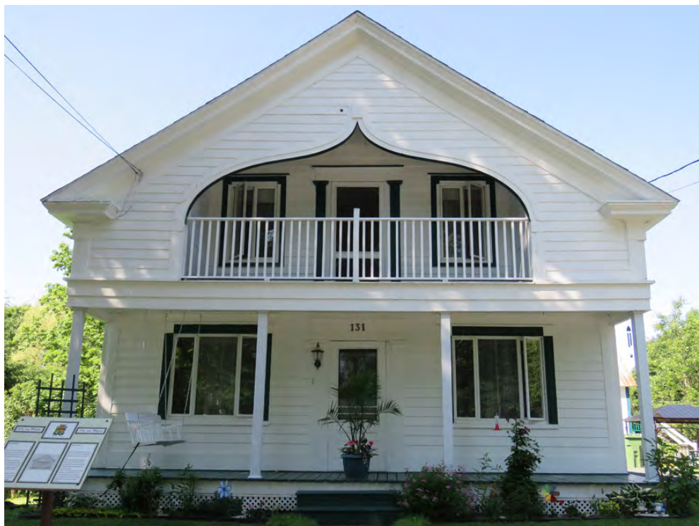
Maison à loggia typique de Danville, dont l'ouverture épousé la forme d'une accolade. Elle est encadrée de retours de corniche qui évoquent le fronton des temples grecs. 131, rue Water, Danville.
