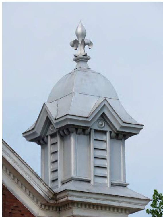
L'un des imposants pinacles au sommet des contreforts qui encadrent la façade de l'église de Saint-Georges. IMG_4552.jpg
