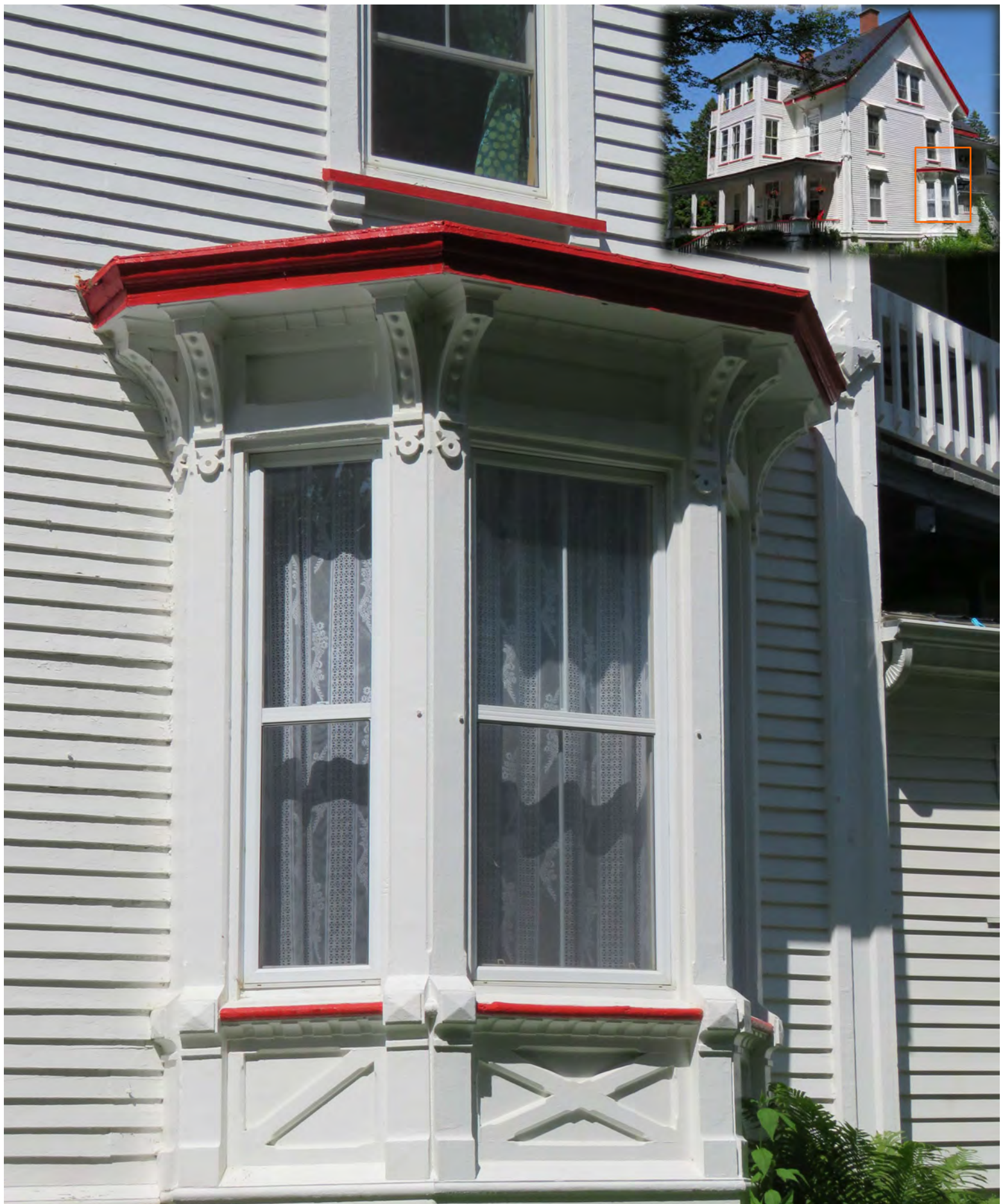
Logette à trois pans, remarquable avec son toit supporté par des consoles doubles et ses panneaux moulurés à la base. 78-80, rue Grove, Danville. IMG_3365.jpg
