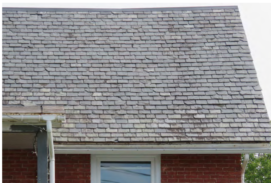
Ardoise sur le toit du 28-30, rue Daniel-Johnson, Danville. IMG_4771.jpg
