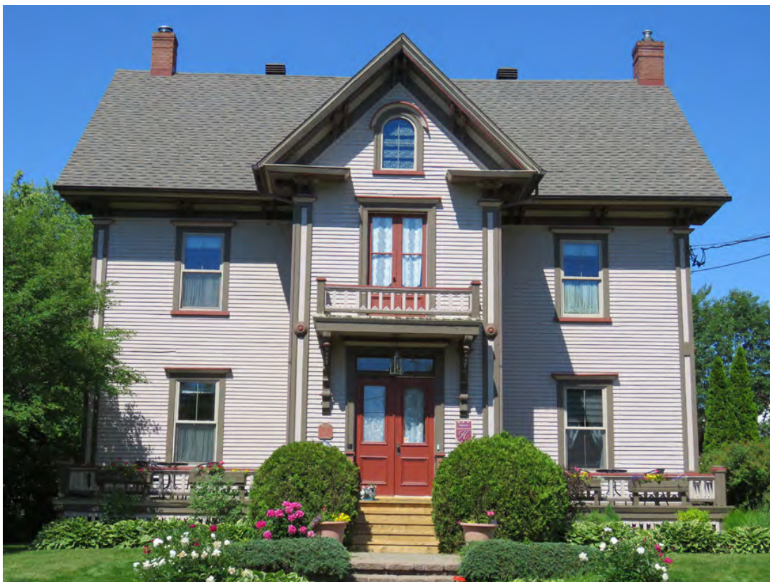
La maison Robert-Thorpe, 91, rue Water, Danville. IMG_3670.jpg
