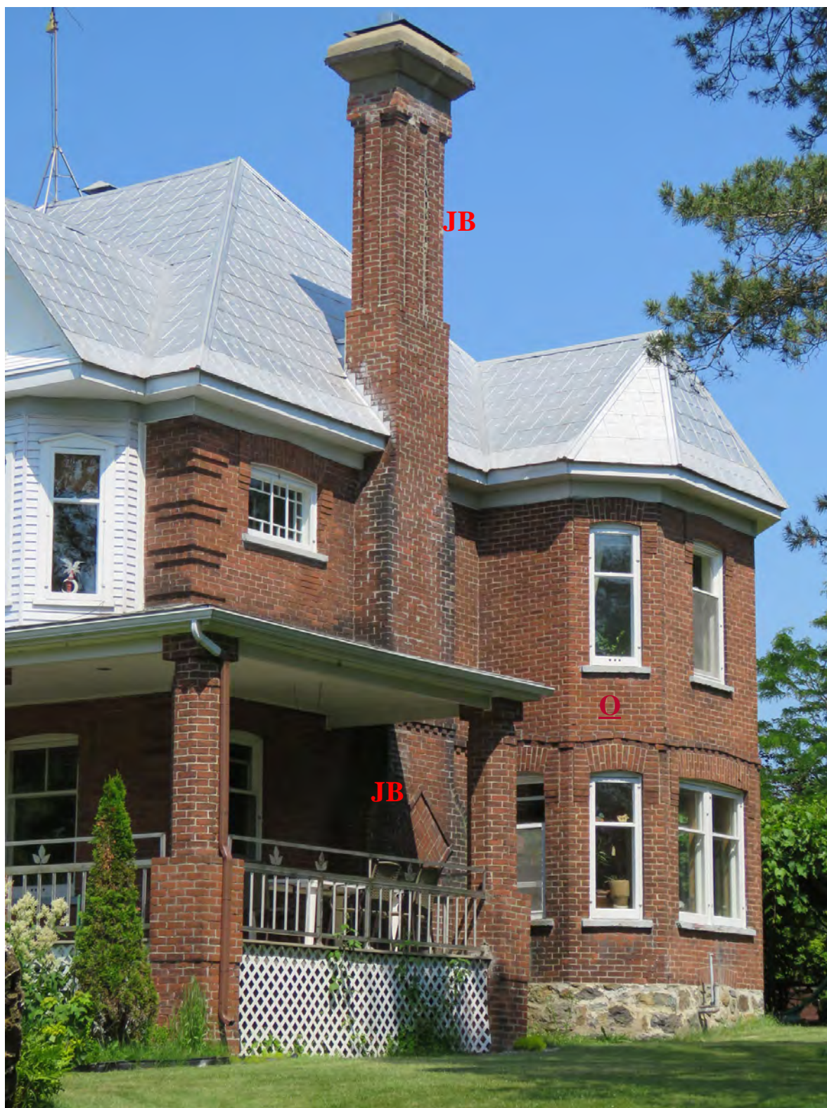
Une composition exceptionnelle : oriel à cinq pans (O), colonnes polygonales sur base carrée, imposante cheminée ornée de jeux de brique (JB), remarquable couverture en tôle matricée. Un bâtiment magistral au 130, rue Grove, à Danville et un parfait exemple d'architecture Queen Anne. IMG_4023.jpg
