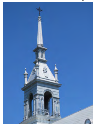
Chambre des cloches et flèche du clocher. IMG_4298.jpg
