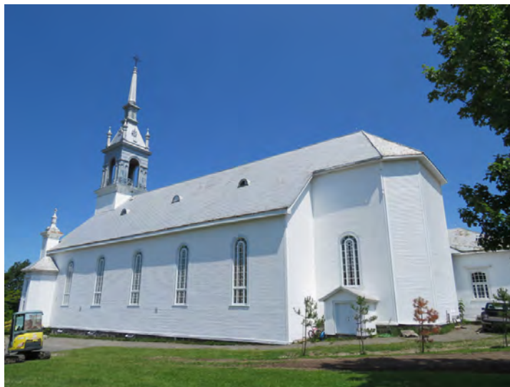
Nef et chœur de l'église de Saint-Adrien. 1606, rue Principale, Saint-Adrien. IMG_4297.jpg
