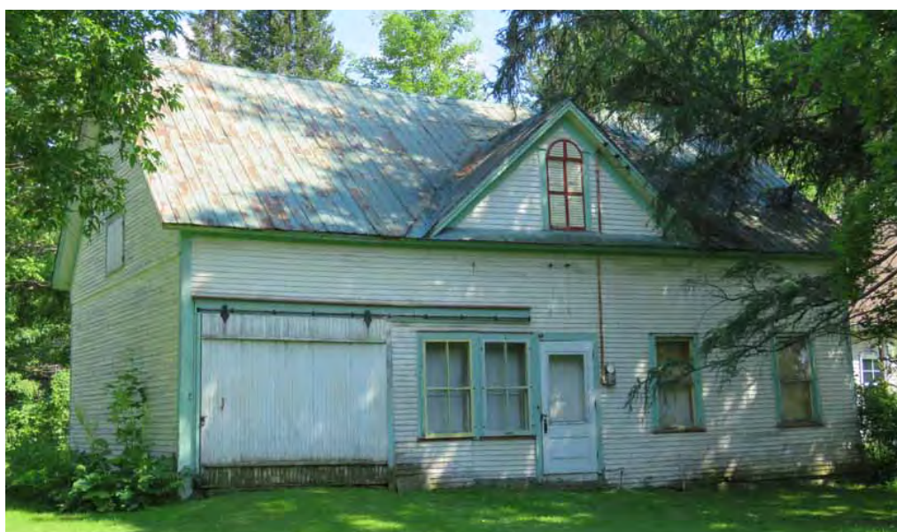
Bâtiment secondaire avec gable au 68, rue Grove, Danville. IMG_3388.jpg
