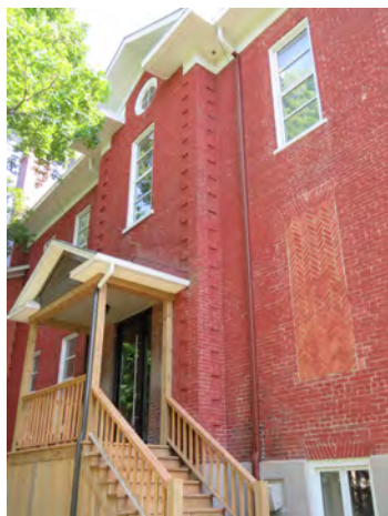
Elévation nord d'origine de l'ancienne académie. IMG_4119.jpg
