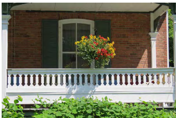
Garde-corps plein avec motifs ajourés dans sa partie supérieure, un modèle vraiment très rare. IMG_3331.jpg
