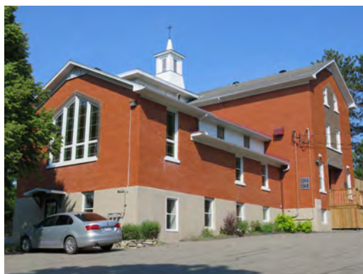
Ailes ouest et sud ajoutées en 1957. IMG_4106.jpg
