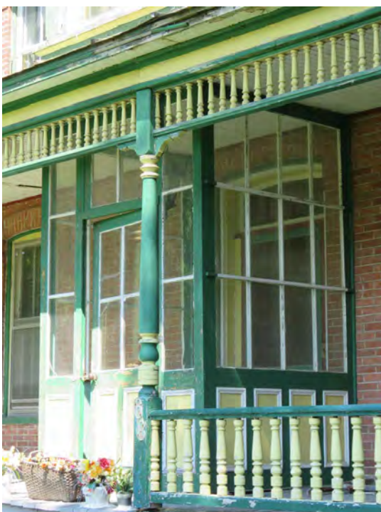
Porche entièrement vitré se signalant autant par sa légèreté que par sa rareté. 68, rue Grove, Danville. IMG_3391.jpg
