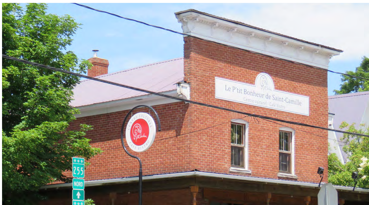
Sur cette maison Boomtown se dresse un imposant mur parapet couronné d'une corniche à consoles. 162 A, rue Miquelon, Saint-Camille. IMG_4678.jpg –
