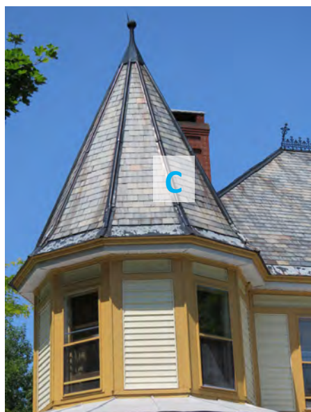
Ardoise sur un toit polygonal. Un cordon de tôle (C) délimite chacune de ses facettes. 89, rue Grove, Danville. IMG_3924.jpg
