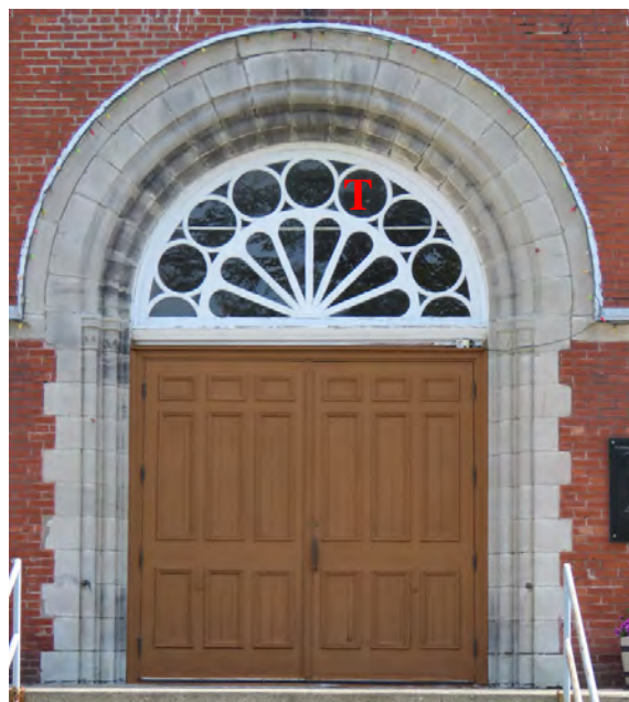
Porte principale à doubles battants et tympan (T) intégrant des motifs analogues à ceux des fenêtres. IMG_4210.jpg
